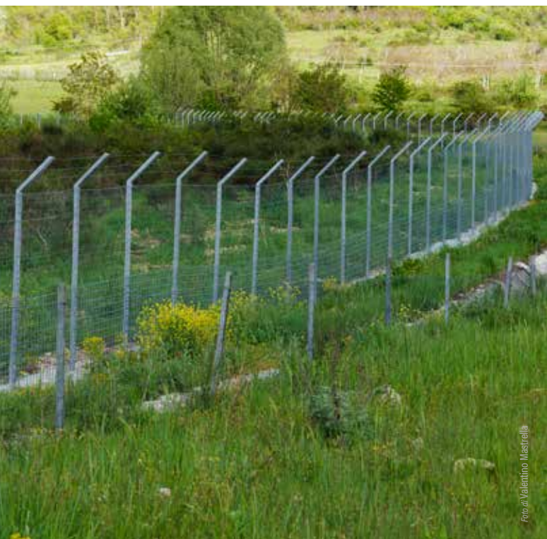
Particolare della nuova recinzione, molto più efficace della vecchia in primo piano
